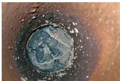
После окончания испытания (трубопровод уплотнен интумесцентным материалом)
